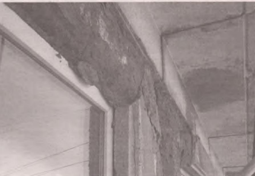
Трескаются обе плиты в квартире и как раз над окнами. То есть в той зоне, где они должны выполнять функцию несущей стены.
