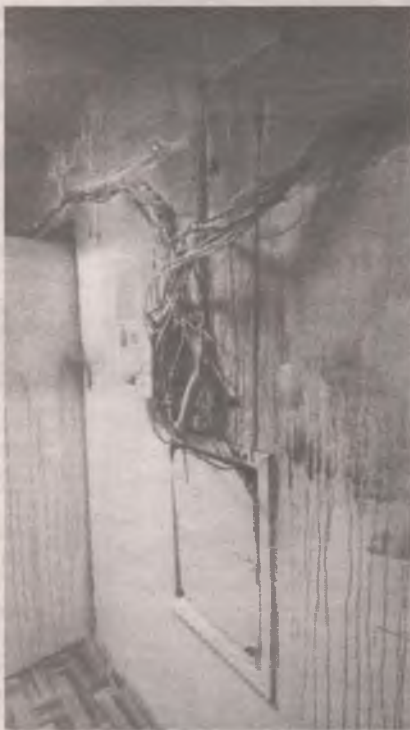
Коридор на втором этаже 4-го блока «Пентагона» и до пожара выглядел не очень, а после пожара совсем плохо.
