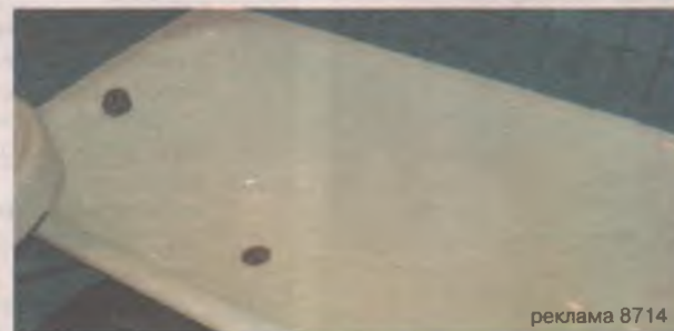
После установки акрилового вкладыша.
