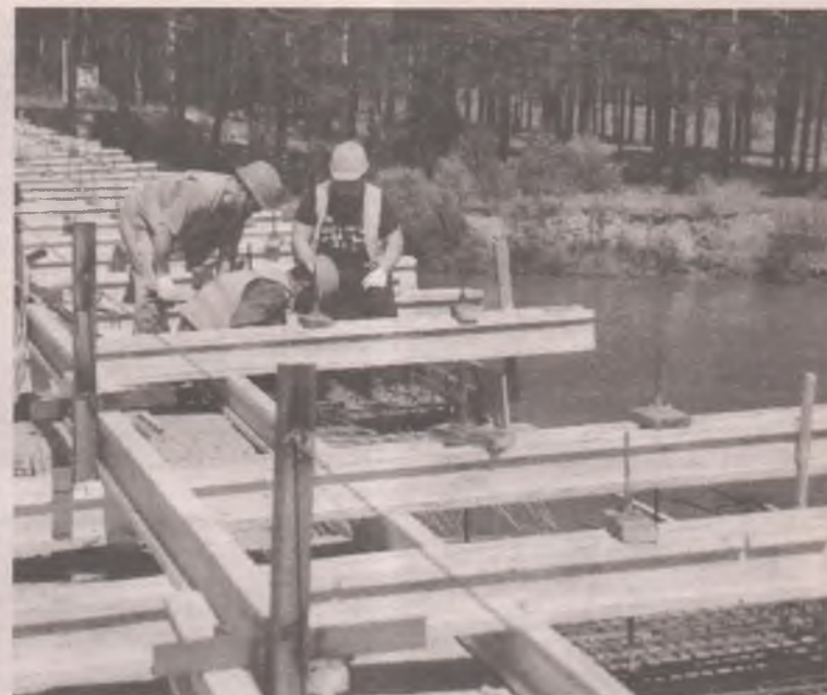
■ Видите металлические штуки с верёвкой на переднем плане? Это бывшее перильное ограждение. За ним – тротуар, который пристраивают к существующей конструкции.
