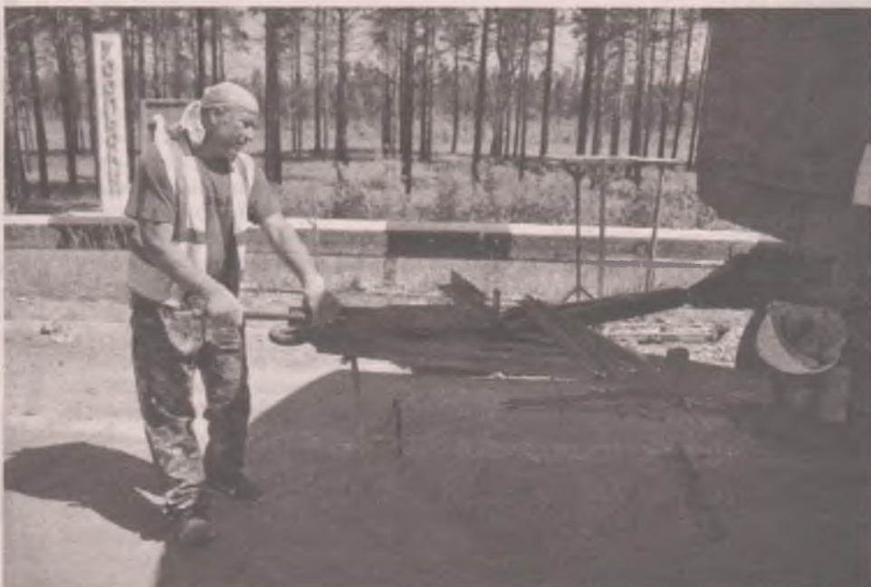
■ Азамат НАРЗИКУЛОВ вручную загибает арматуру, делая из неё четырёхугольники определённых размеров.
