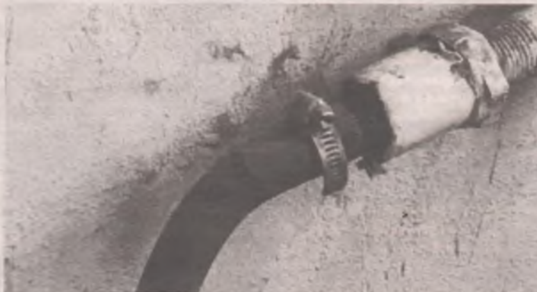
■ Внимание – старый шланг легко пропускает газ, и он идёт в квартиру!
