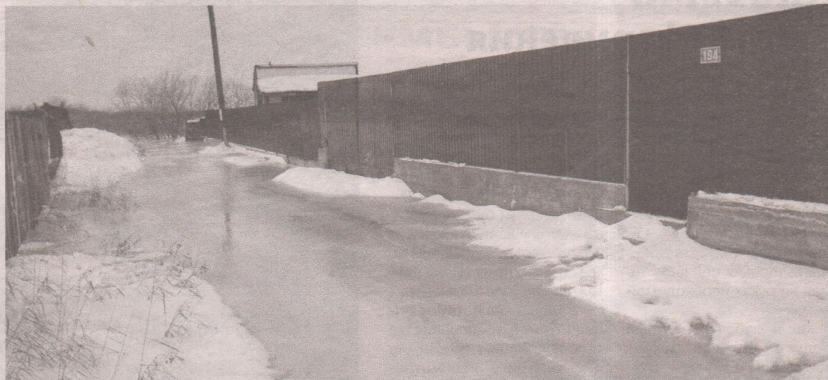
■ На участки вода пока не зашла, но улицу затопило полностью.
