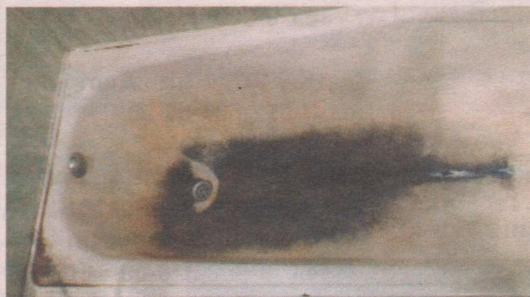
■ Ванна до установки акрилового вкладыша.
