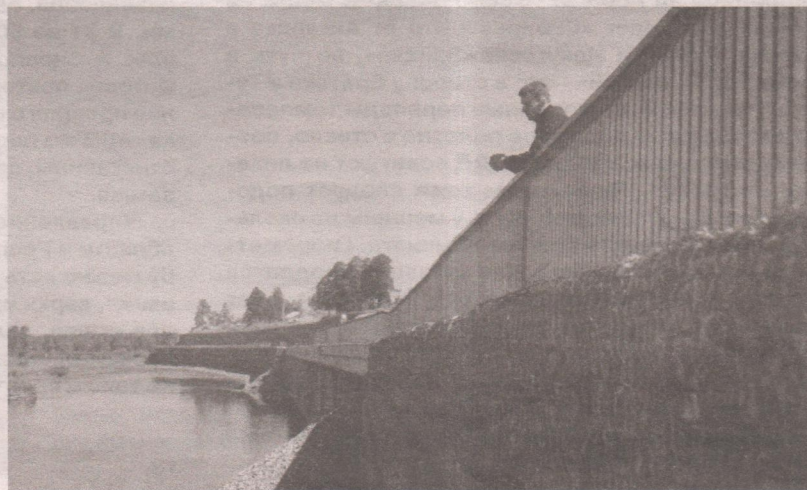
■ С начала сентября на будущей набережной реки Китоидёт строительство и озеленение первой очереди, выхода к набережной, – бульвара Пассионариев.
