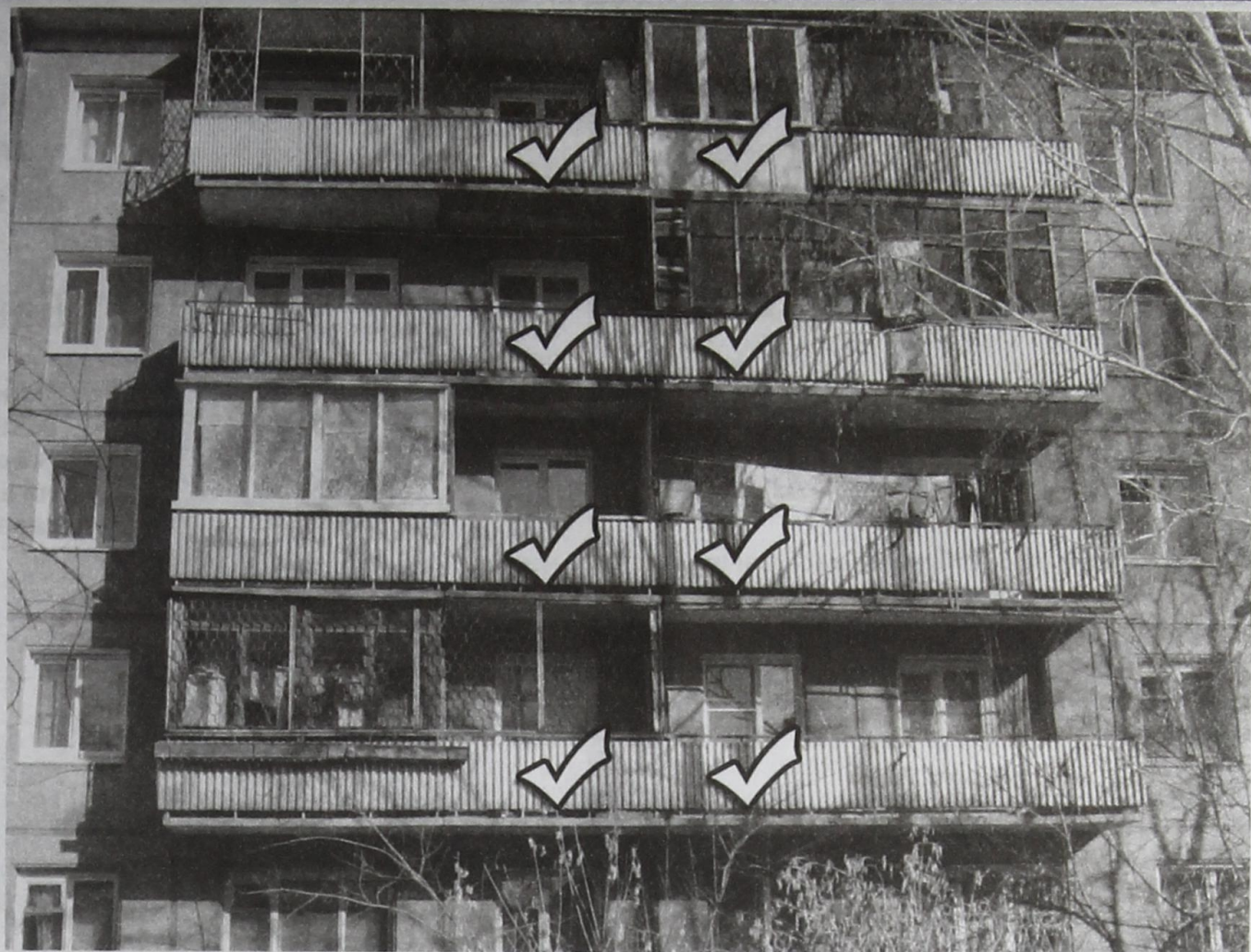
■ Галочками на фото помечены окна, из которых выход на балкон при строительстве дома не предусмотрен. Однако видно, кто разделил спорный балкон, а кого соседи замуровали.
