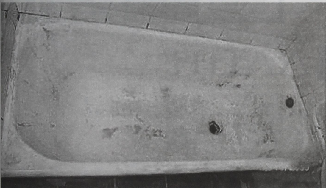
До установки акрилового вкладыша в ванну.
