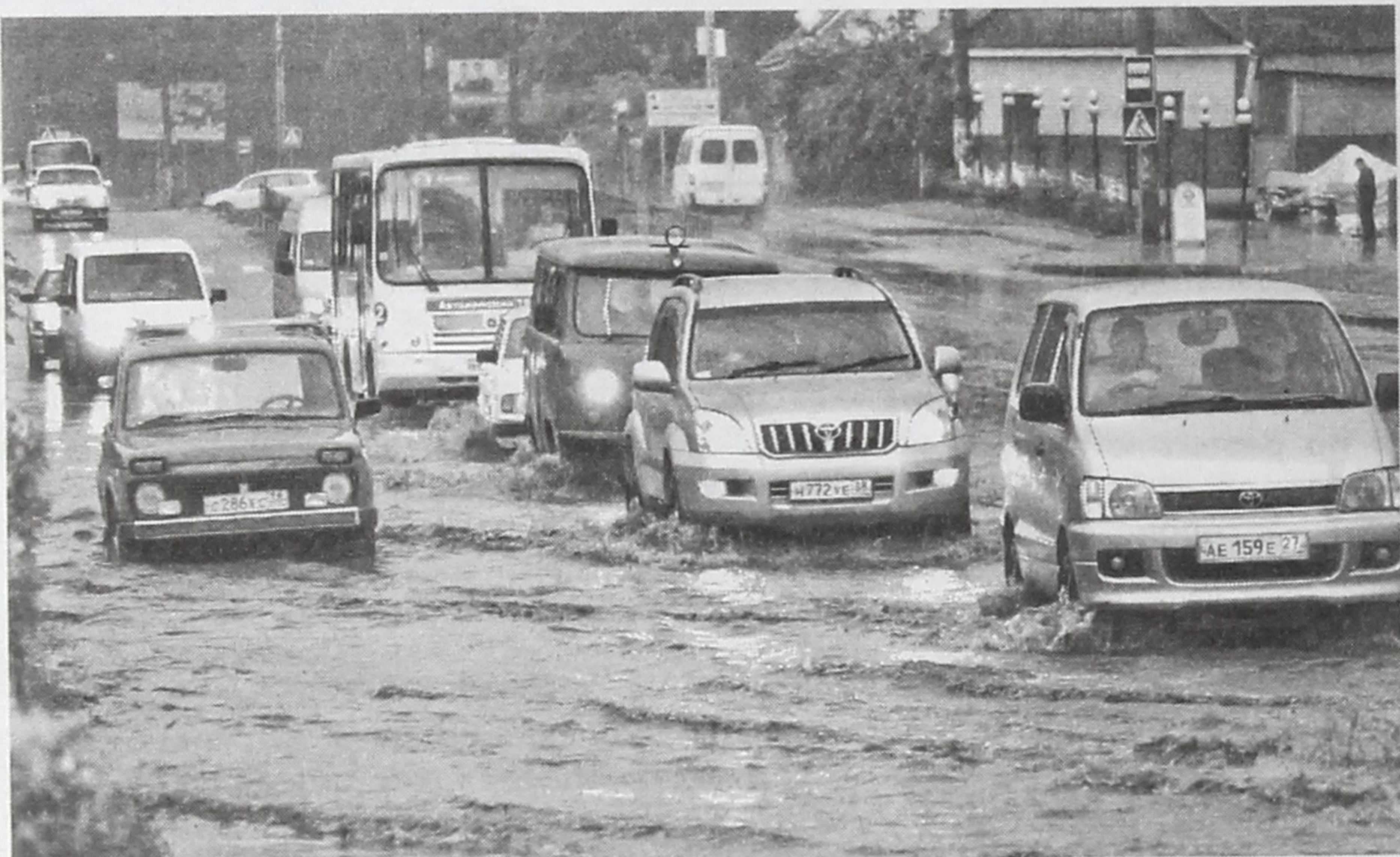
■ Когда ливнёвка не чищена, а асфальт уложен с нарушением технологии, любой дождик превратит дорогу в реку.
