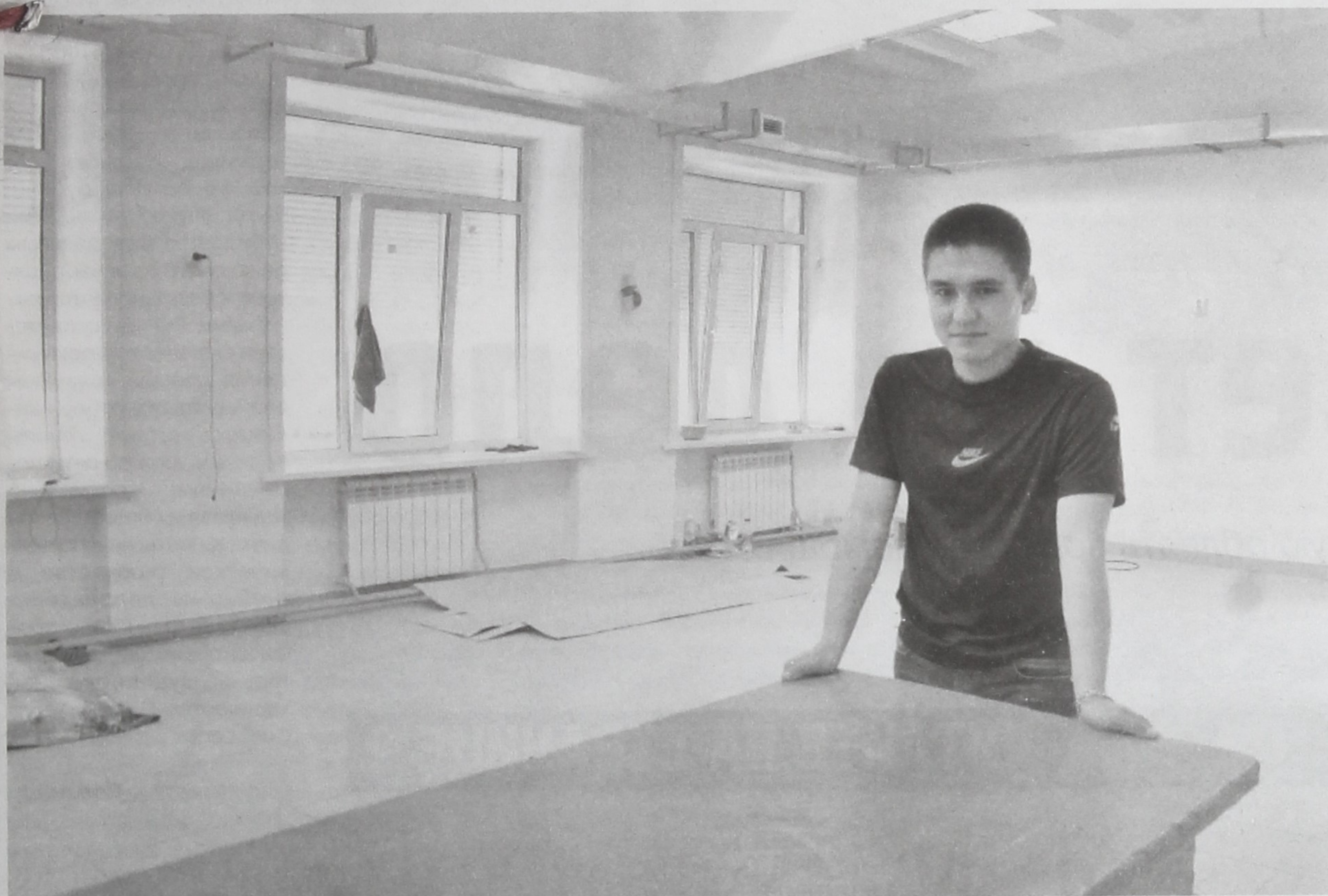
■ Игорь БАШИНОВ, и.о. завхоза школы №21: «Скоро в отремонтированной мастерской появится новое оборудование».
