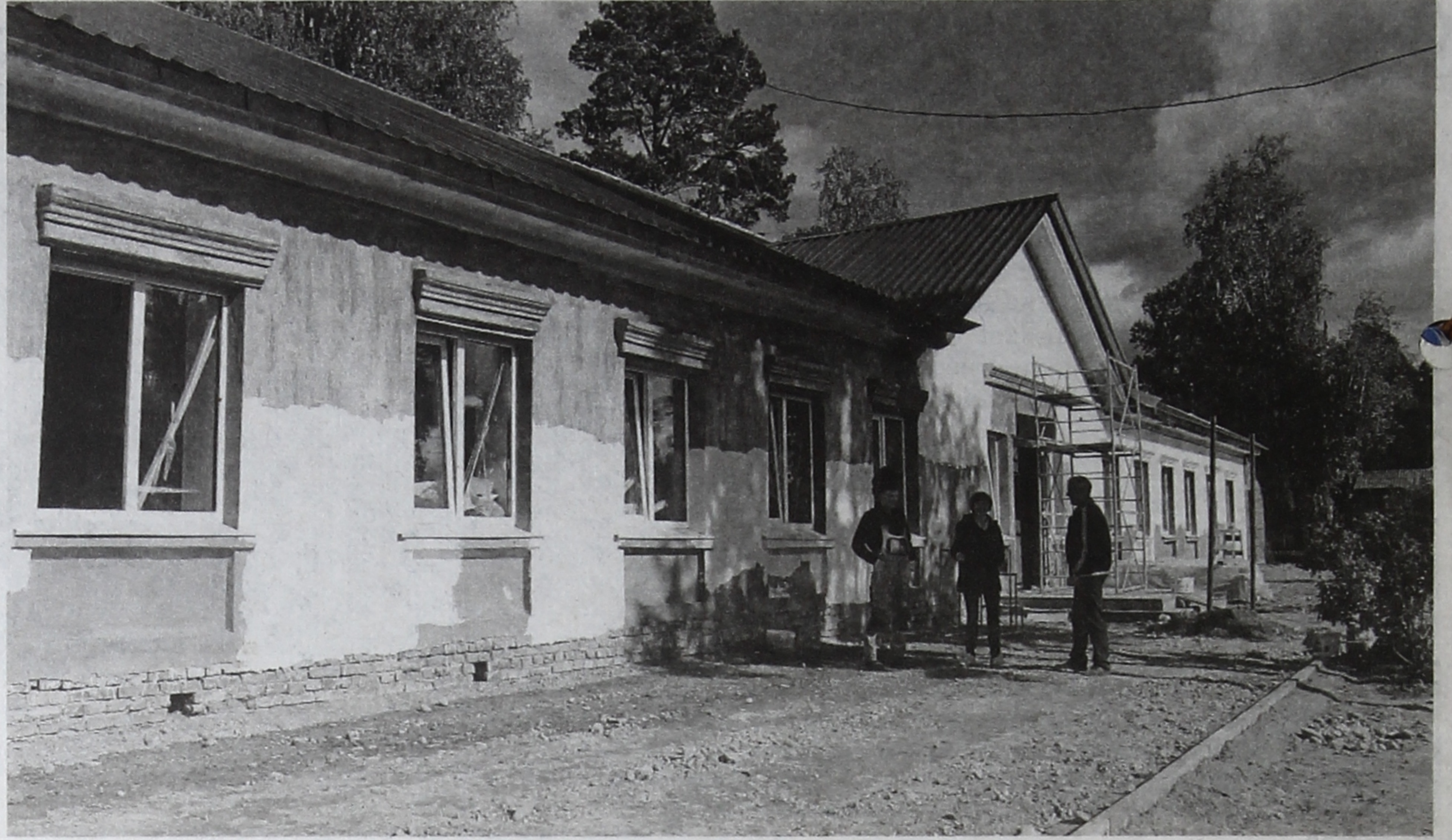
■ Детский сад в Юго-Восточном после большого ремонта обещают открыть уже в ноябре.
