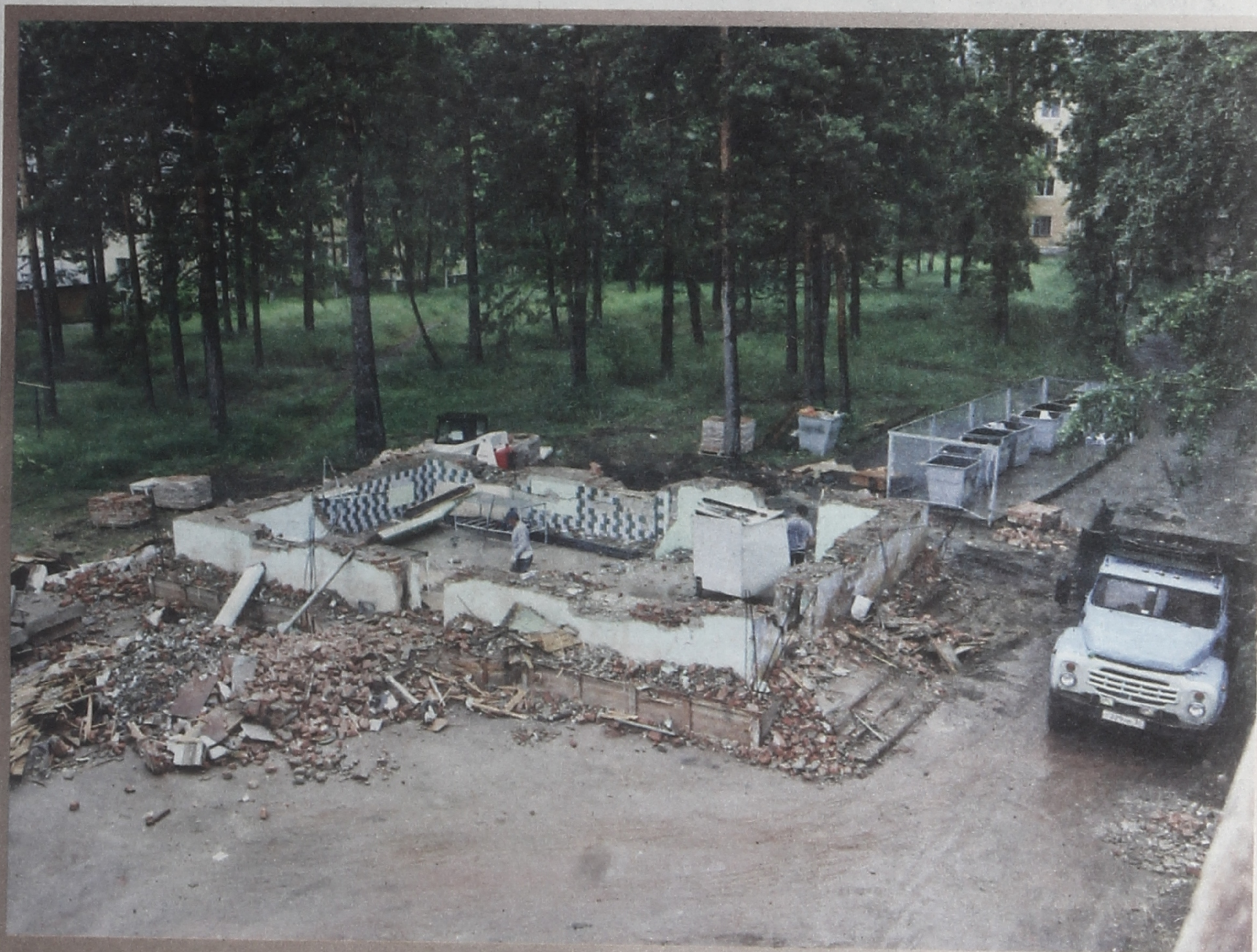
■ 12 июля 2013 г. Здание прачечной снесено.
