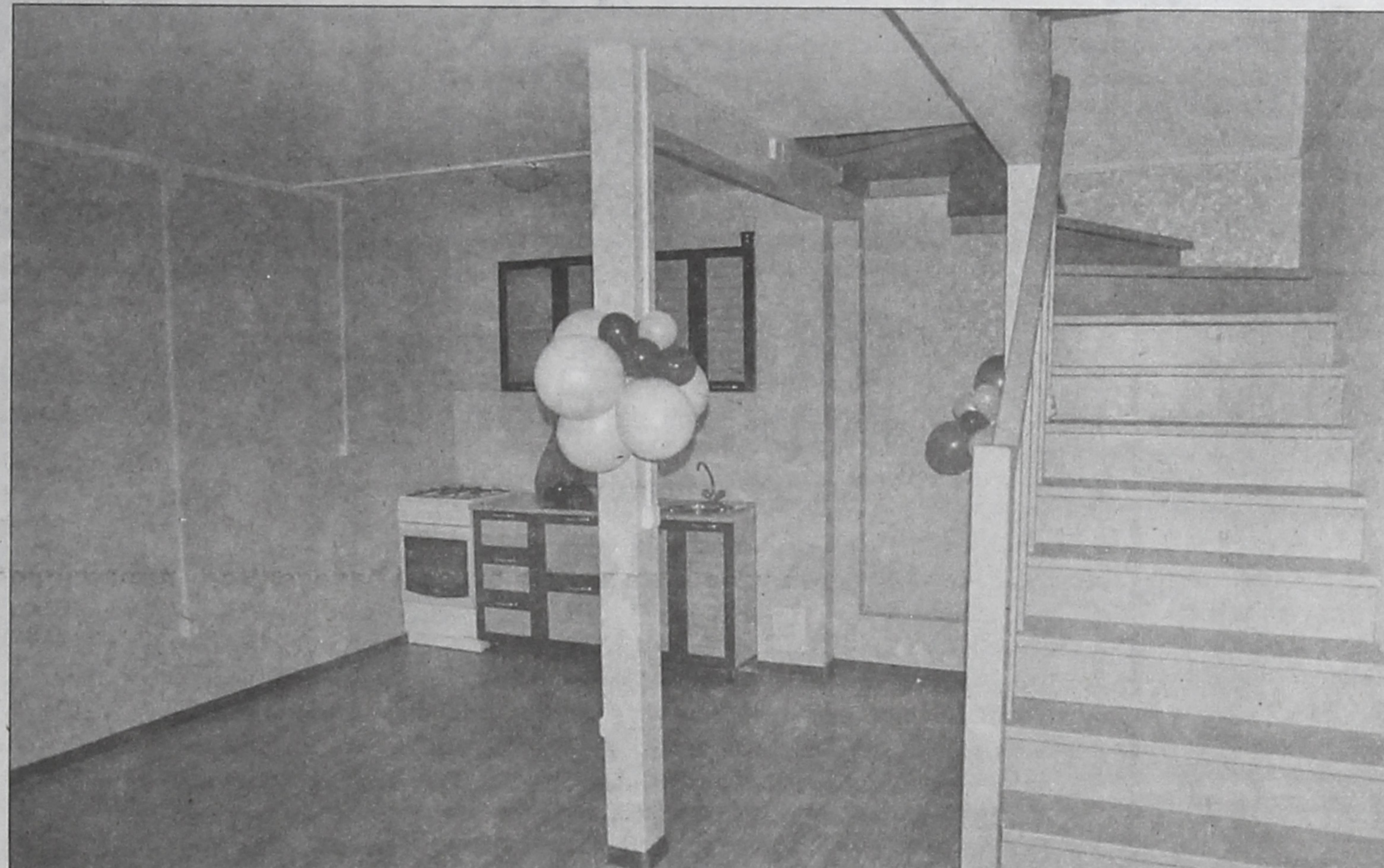
Планировка двухэтажных квартир в «умном» доме необычная. Все устроено так, чтобы максимально сберечь ресурсы. К примеру, лестница является еще и теплообменной шахтой, распределяющей тепло между этажами.
