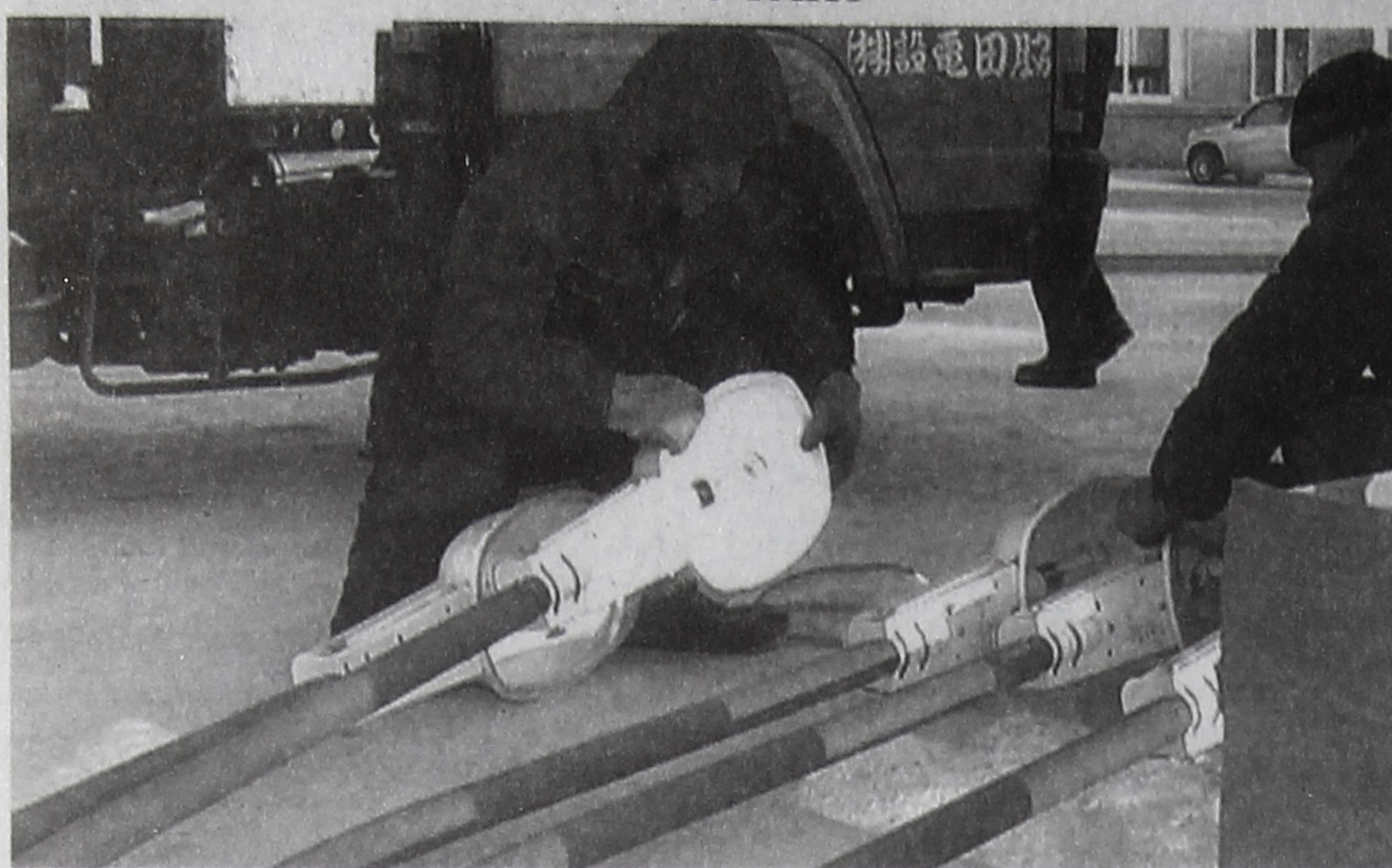
■ Площадь Ленина обзавелась двумя новыми светильниками типа «ромашка». 18-метровые мачты оснащены абсолютно новыми энергосберегающими натриевыми лампами взамен устаревших ртутных светильников.
