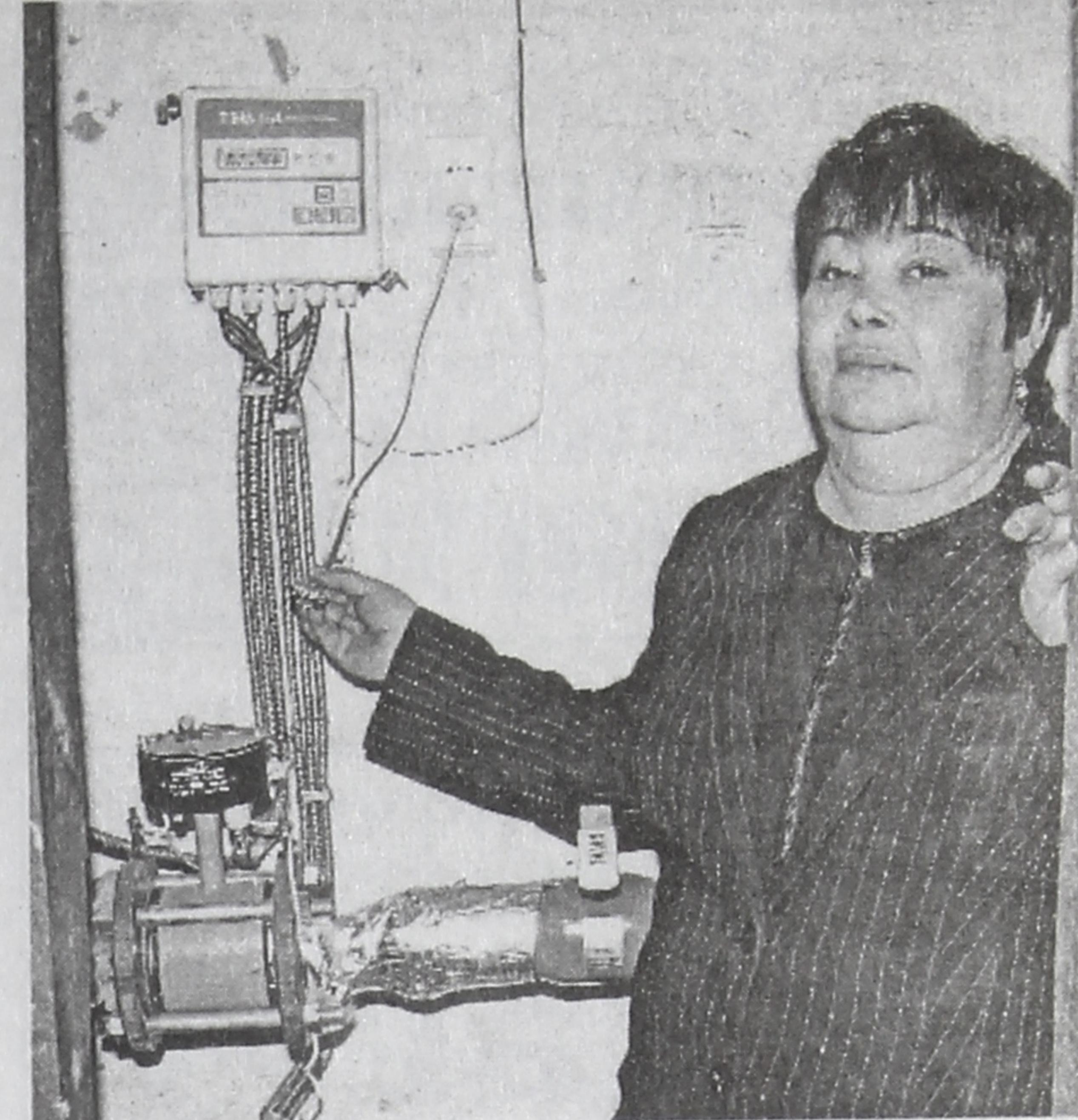
■ Этот счетчик установлен в доме №7 квартала 55, и весь дом рассчитывается за тепло и горячую воду по нему. Чтобы снять показания, нужно подключить к счетчику ноутбук со специальной программой, - объясняет начальник участка Татьяна ЩЕКИНА.
