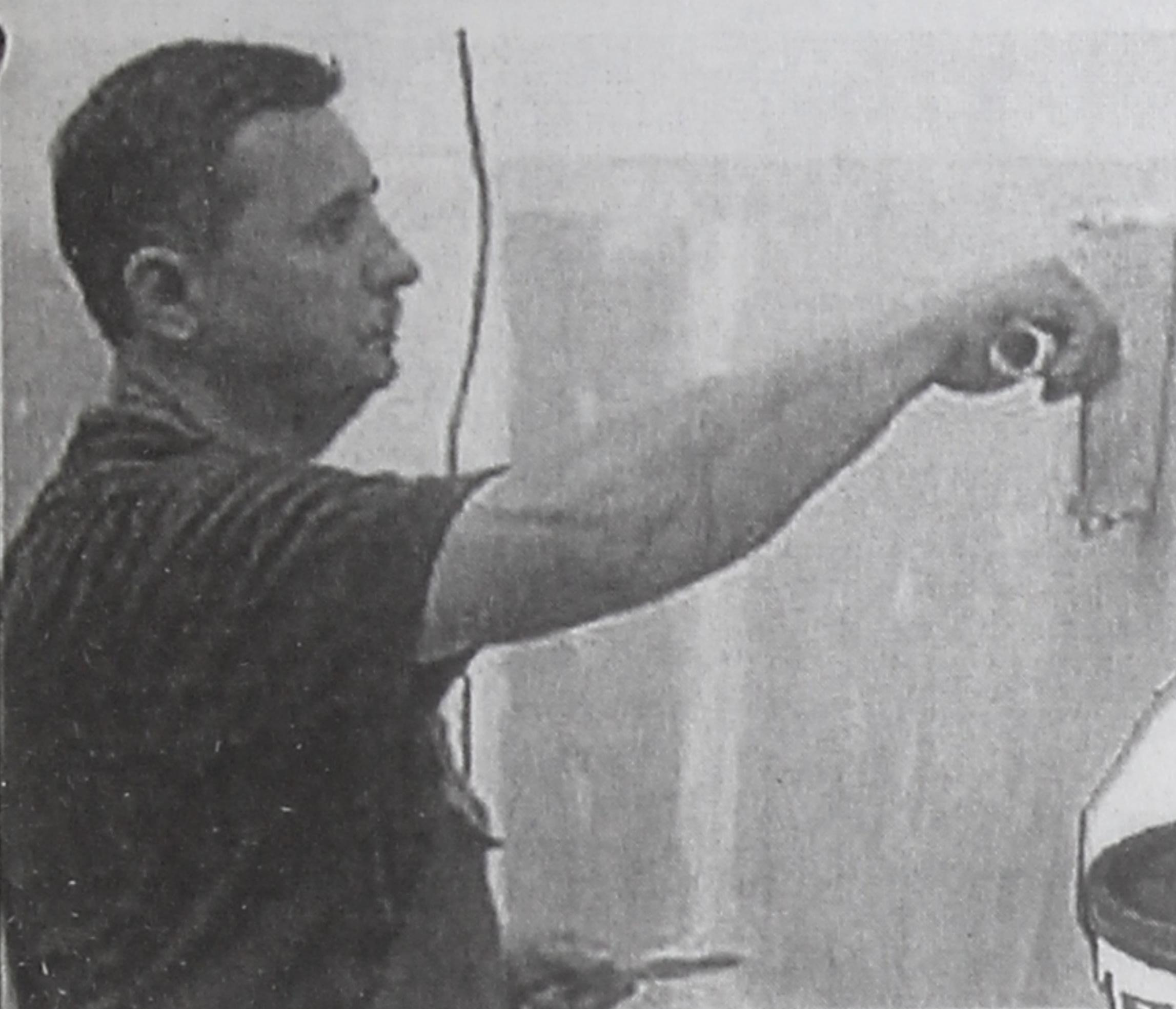
■ Грунтовку «Бетоконтакт» наносить щеткой или валиком.
