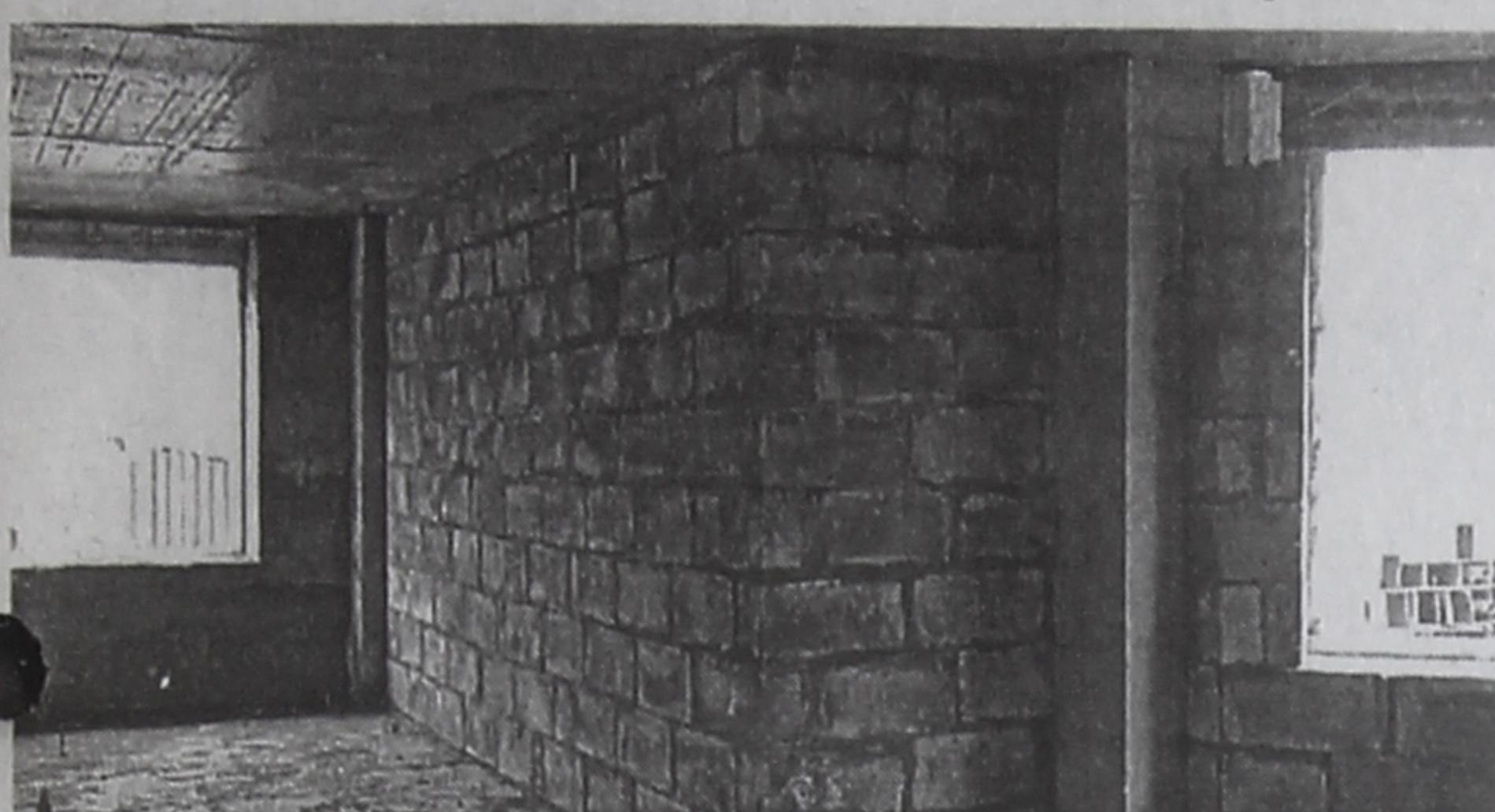
Небольшая плотность пенобетона приводит к снижению нагрузки на несущие конструкции.
