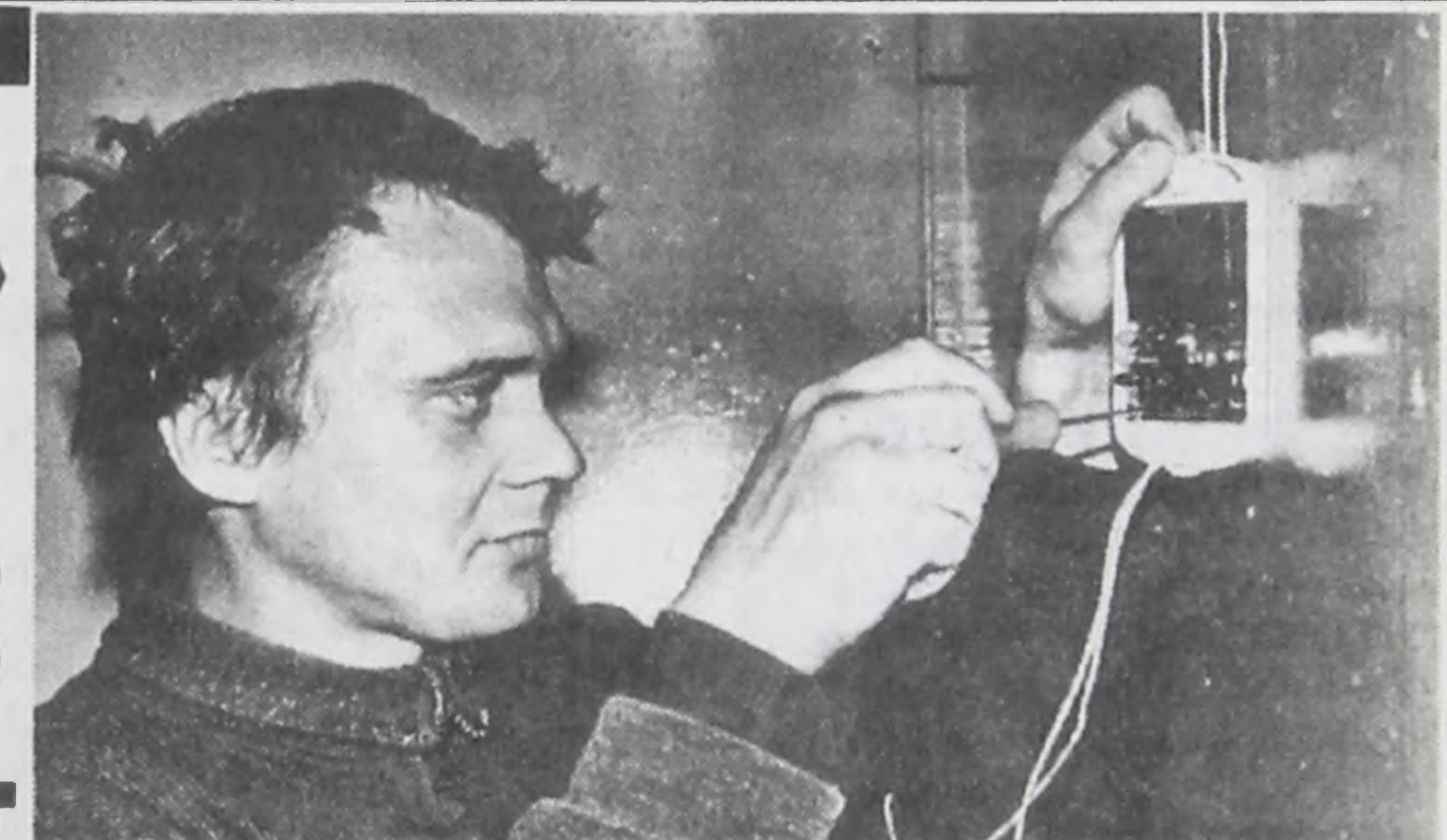
Николай Пежемский, монтажник ОПС, устанавливает датчик охранной сигнализации.
