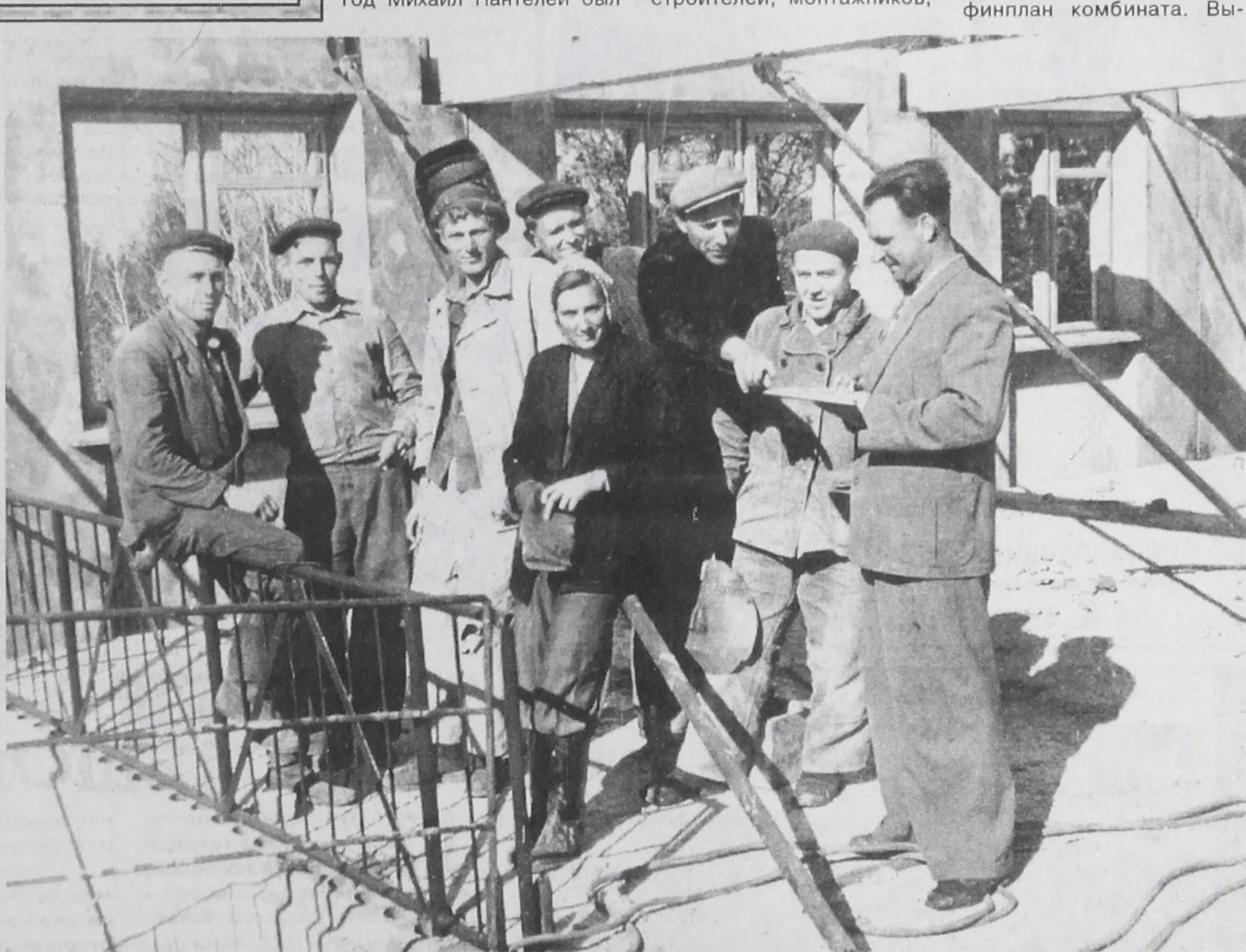
Бригада Владимира Пирого (первый строительный район) на монтаже жилья крупноблочных домов. 1959 г.
