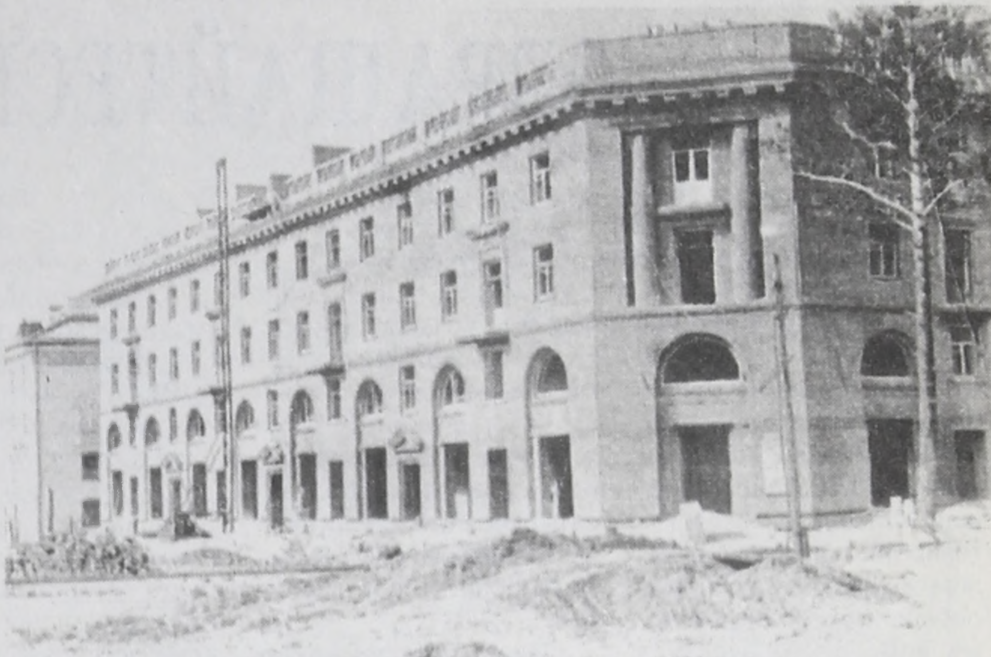
Строительство дома на площади Ленина (угол ул.Ленина и К.Маркса).
