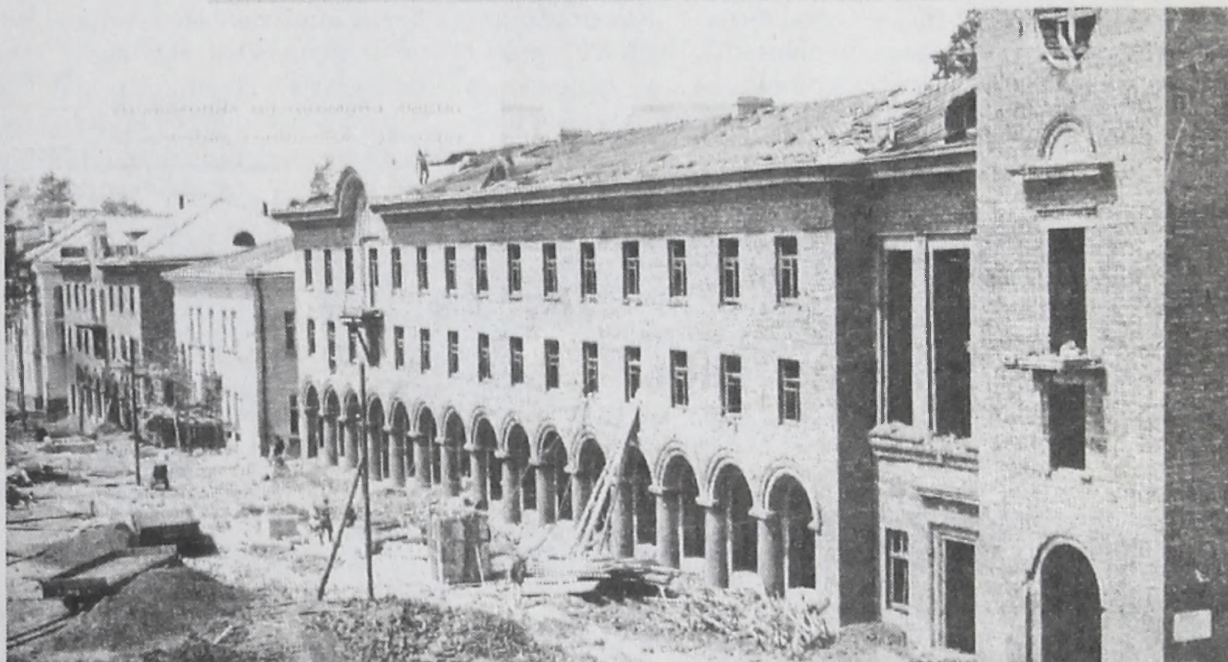
Дом связи и кредитных учреждений.
