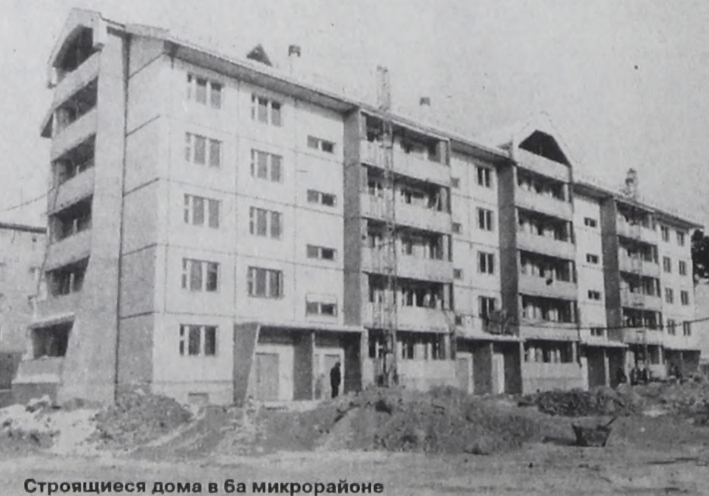
Строящиеся дома в 6а микрорайоне
