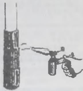
свою отработанным автомобильным маслом. В старину использовали смолу и обжиг до обугливания той части, которая находилась в земле. Безусловно, лучшая порода дерева для фундамента - это лиственница.
