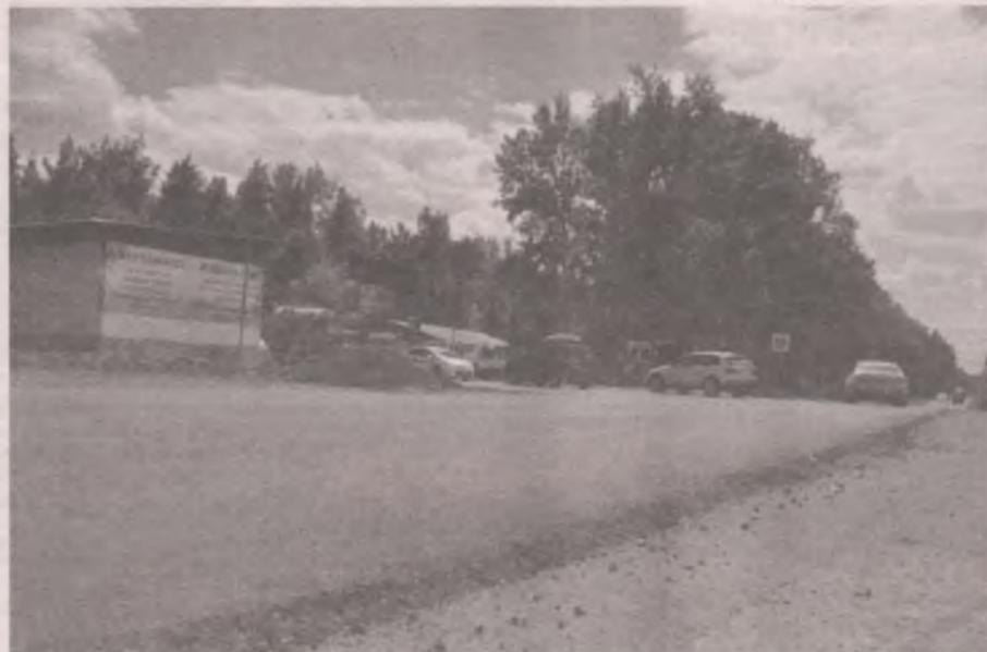
Ближайший наглядный пример - укладка асфальта на участке южного подъезда к Ангарску, рядом с кладбищем «Березовая роща». В середине июня на ремонт автодороги зашел подрядчик. После его работы дорога стала немногим лучше, чем до ремонта. Автомобили, попавшие на этот участок, плыли по асфальтовым волнам, как во время морской качки. Кроме того, даже визуально дорога стала заметна уже.
