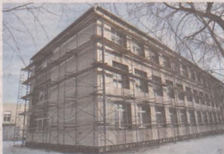
Капитальный ремонт школы №38
