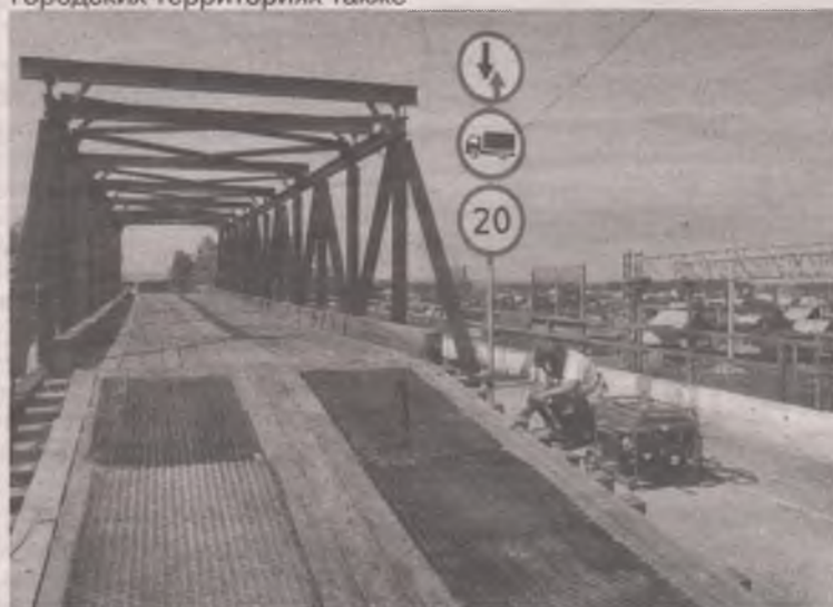
Виадук будет отремонтирован
