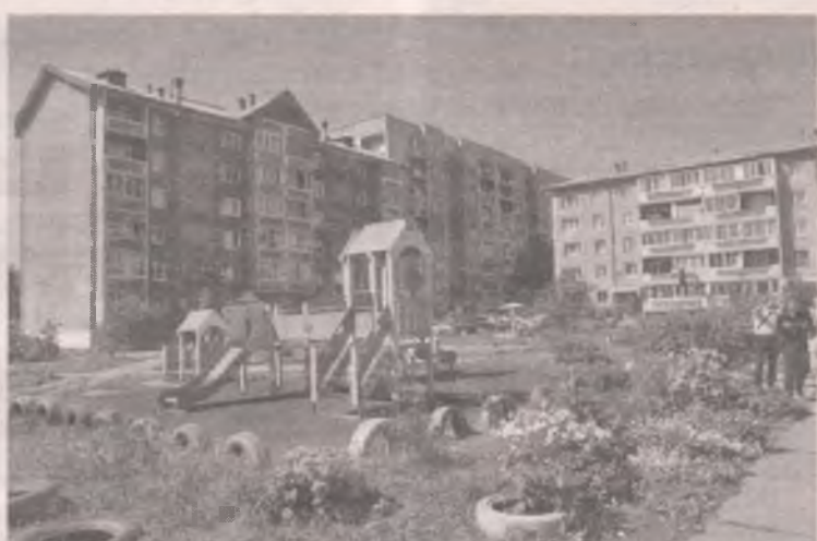
В 2019 году в Ангарском округе благоустроено 16 дворовых территорий многоквартирных домов:
