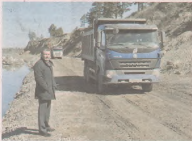
2017 год - отсыпка породы в фундамент набережной
