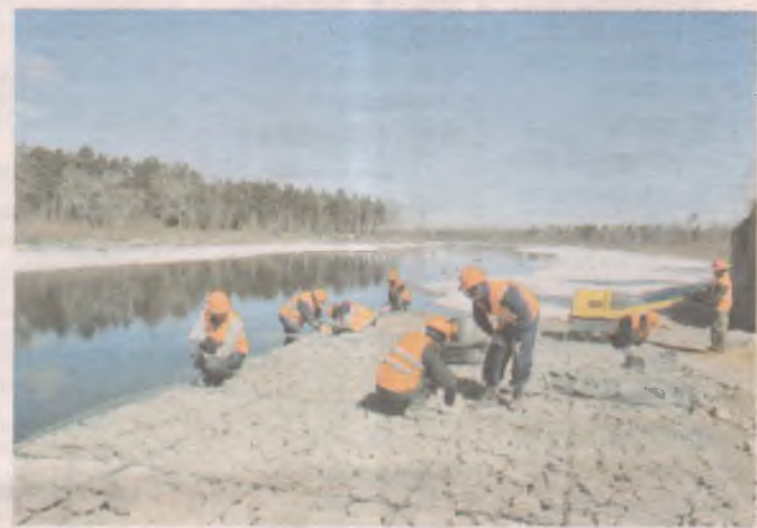
2017 год - установка габионных конструкций
