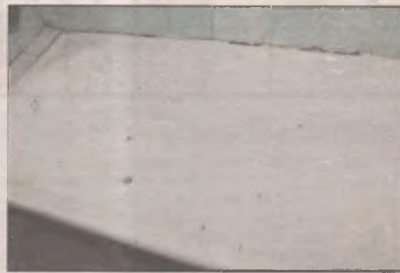
После установки акрилового вкладыша
