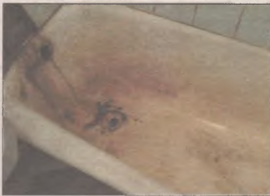
Ванна до установки акрилового вкладыша
