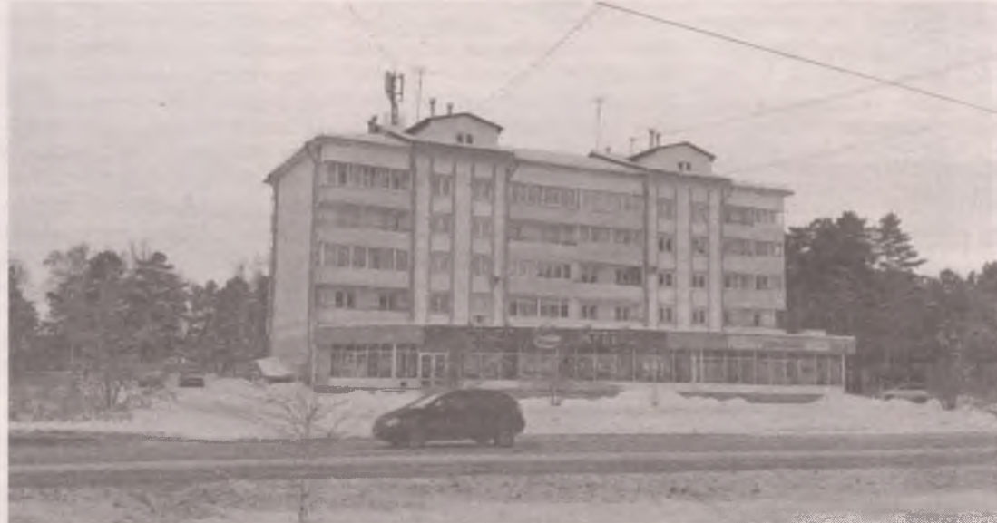
Несмотря на то, что 34 микрорайон изначально предполагался под жилую многоэтажную застройку, жители единственного построенного здесь многоэтажного дома хотят остаться в одиночестве в целом микрорайоне
