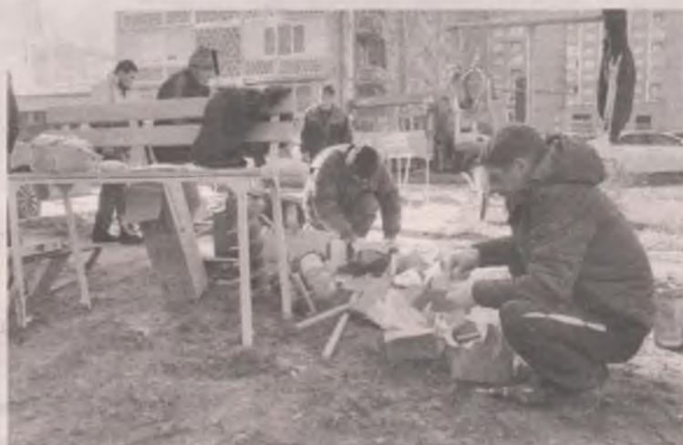
Во дворе 12а микрорайона нас встретила бригада строителей, завершающая установку детского городка
