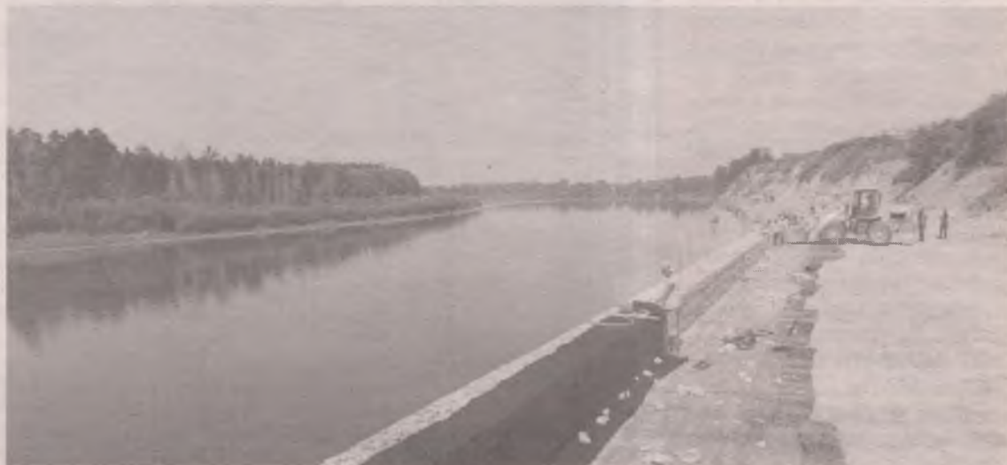
В стадии завершения находится первый ярус габионных конструкций.
