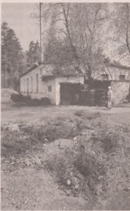
Котельная Сибизмира. На переднем плане корд от сгоревших покрышек
