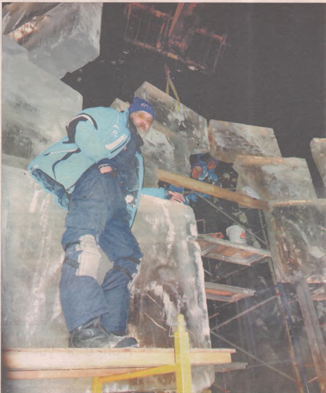
«Caterpillar» нам поможет! (ночной монтаж 25-тонной конструкции)
