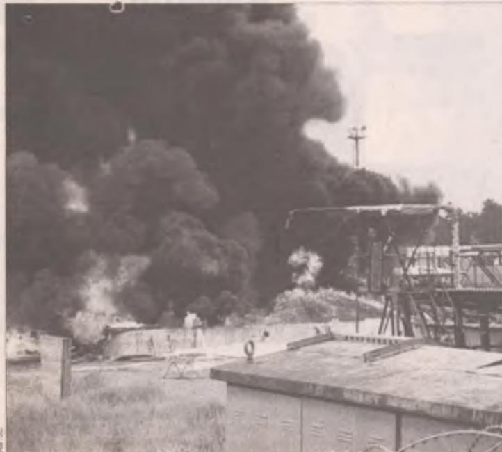
Комиссией, проводившей расследование, было установлено, что основными причинами случившегося явились взрыв паровоздушной смеси углеводородов. Причинами взрыва в равной степени могли стать тепловое воздействие внешнего источника зажигания, тепловое проявление электрического тока или разряда статического электричества. Негативную роль сыграло использование резервуара противопожарной воды для хранения нефтепродукта.
