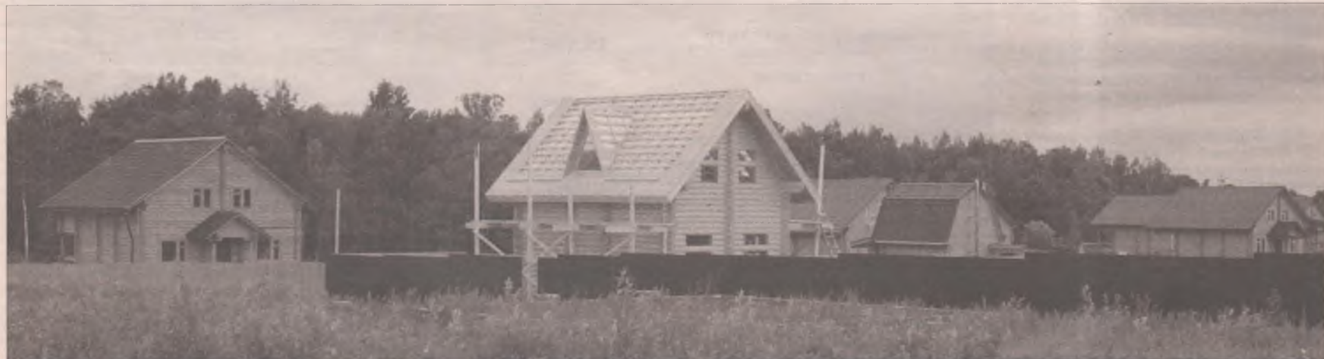
Бум коттеджного строительства пришёл в наши края
