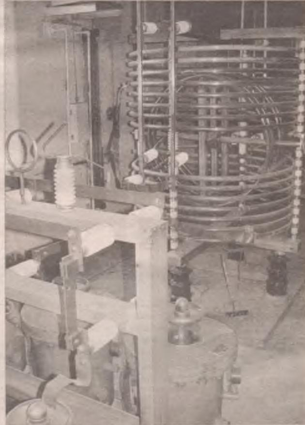
Дубовые каркасы гигантских медных катушек не дали ни одной трещинки с 1938 года!
