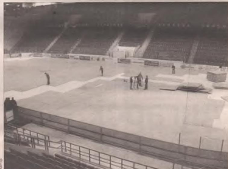
Час-два, и при температуре ПОД покрытием -5, НАД покрытием +13
