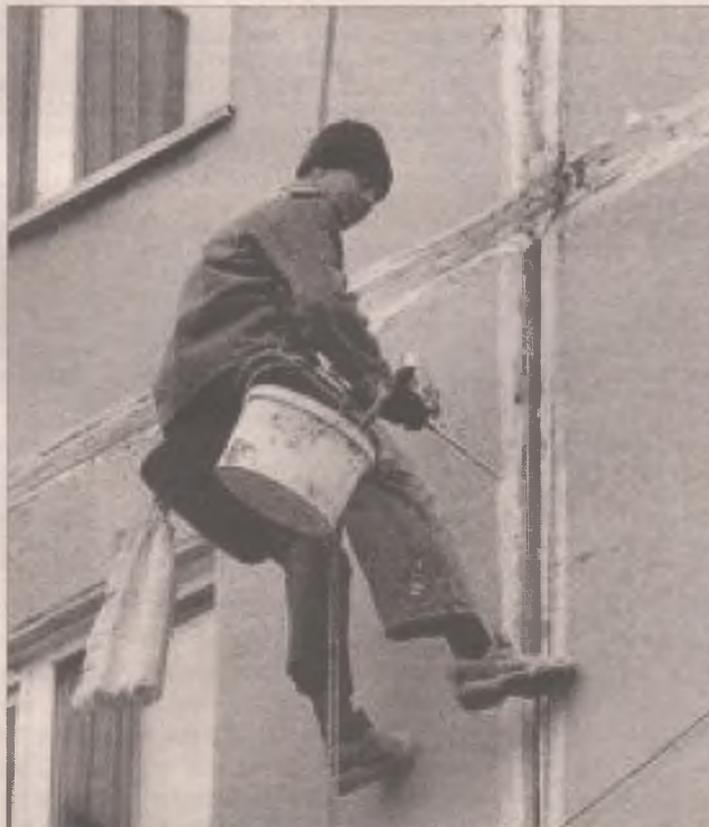
Дырки в межпанельных швах - одна из причин перерасхода тепла
