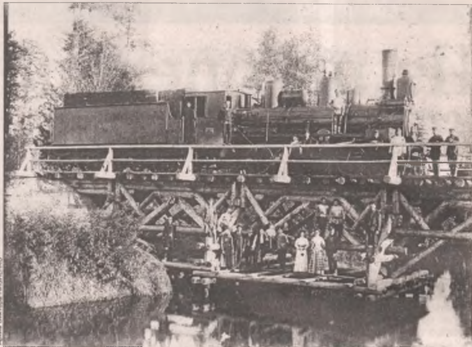
Так испытывали мост при строительстве Транссиба
