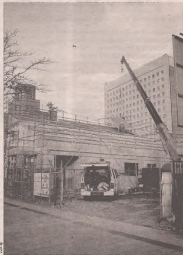
Японские частные дома - это набор брусков и многослойной фанеры. Такая конструкция имеет хорошие шансы устоять во время землетрясения, но бессильна перед цунами
