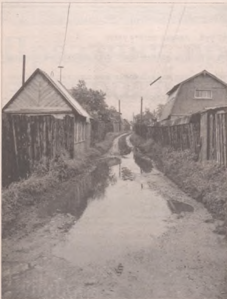
Дороги давно требуют ремонта
