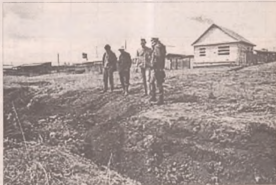
В четверг, 13 мая, отец Сергея работал на экскаваторе - добывал глину для отсыпки опалубки для дома. Глину рыли через дорогу от дома, в яру. В обед, около часа дня, ковш машины наткнулся на какое-то препятствие
