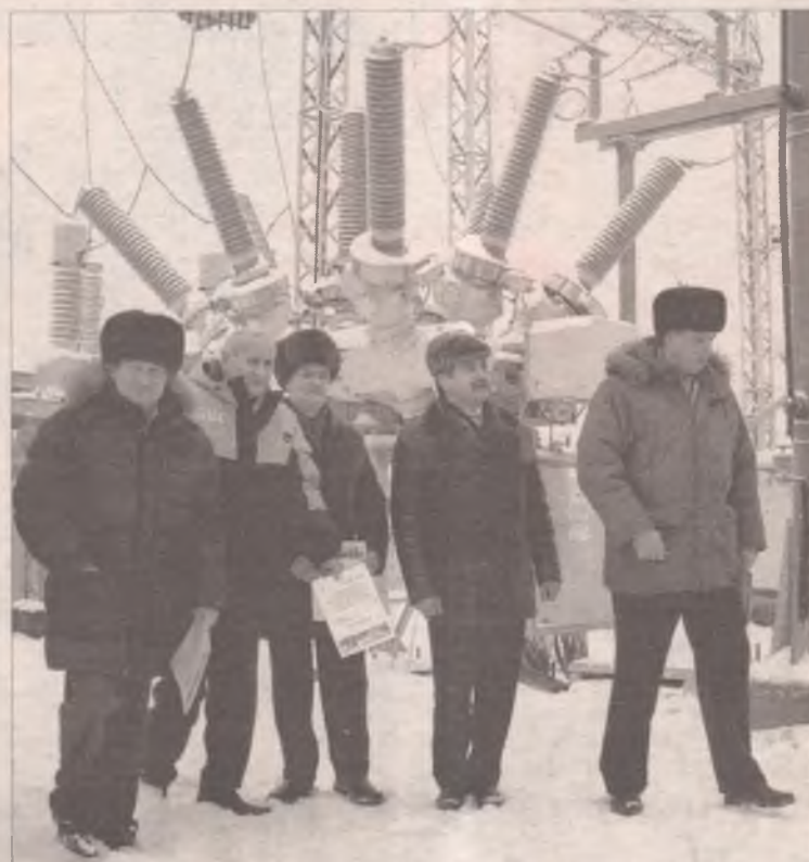
* В День энергетика, 22 декабря, в Ангарске состоялось торжественное открытие электроподстанции «Прибрежная». Важный для города объект расположился в районе Старицы в 30 микрорайоне.
