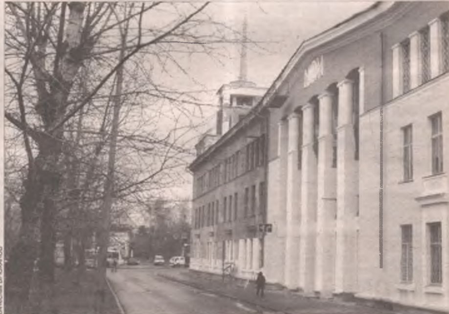
Идут отделочные работы
