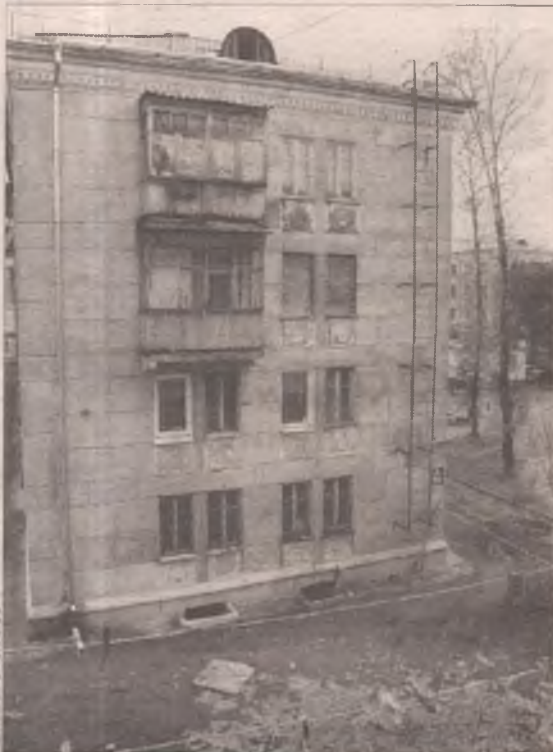
Квартал А, дом 18. Капитальный ремонт по федеральной программе уже начался. В доме меняют кровлю. По итогам ремонта 5 процентов его стоимости оплатят жильцы, а 95 процентов - государство
