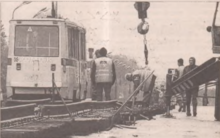
Идет замена трамвайного полотна
