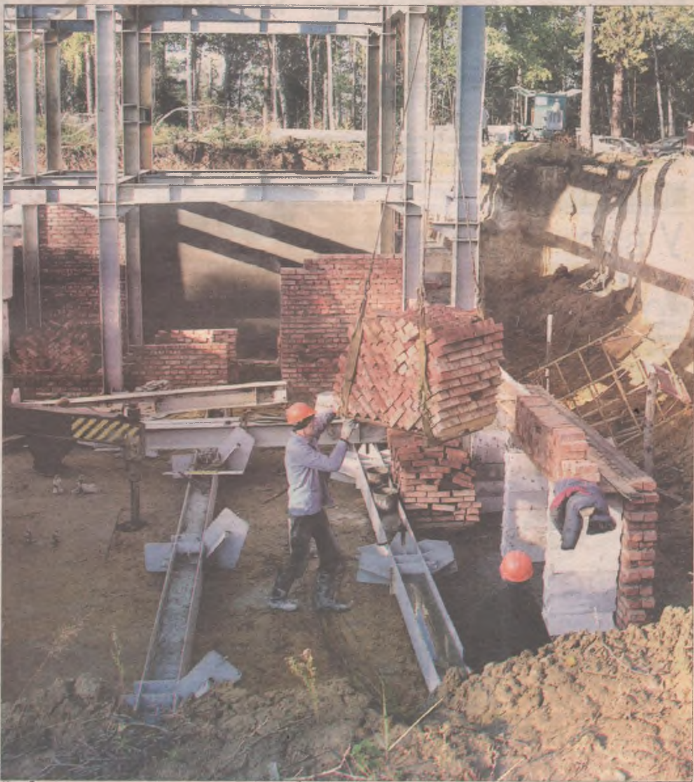
На объекте вовсю идет строительство. На месте будущего здания пока сваи и кирпичи, но к марту его планируют достроить и провести здесь первые областные соревнования
