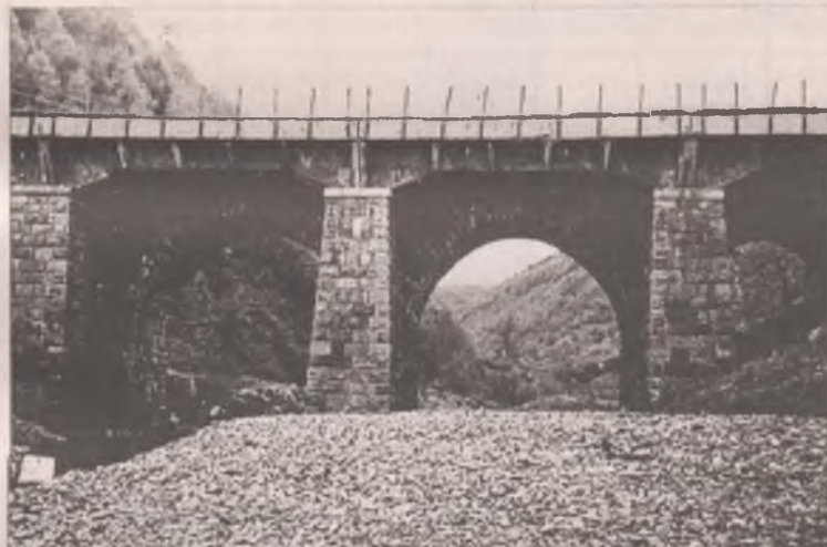
Мост через реку Маритуй построен в начале прошлого века
