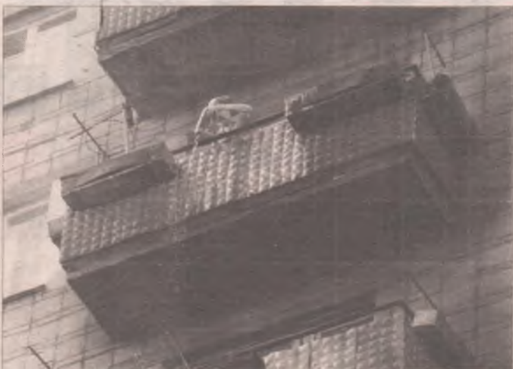
Пожар помогали тушить соседи, чьи квартиры сильно закоптились от дыма
