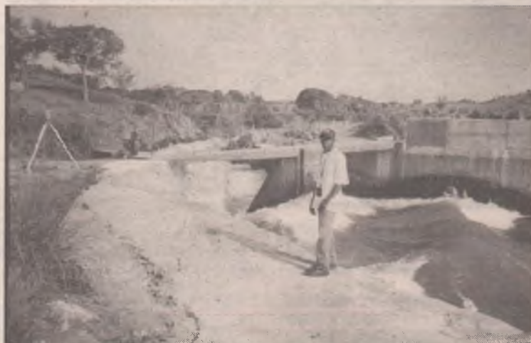
ГЭС на Шикапе начинали строить португальцы, а спустя много лет, при дальнейшем возведении станции, их постройки в качестве фундамента использовали российские специалисты
